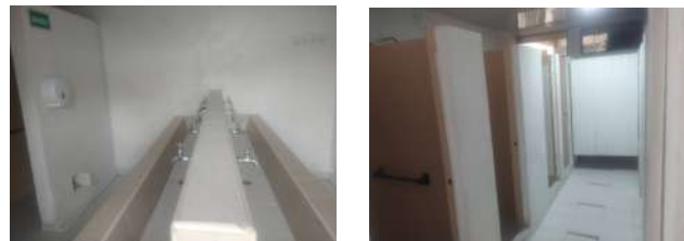
DESCRIPCIÓN: BATERIAS SANITARIAS
