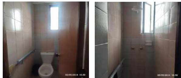
DESCRIPCION: BATERIAS SANITARIAS PARA PARTICIPANTES
